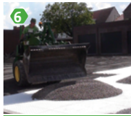
6 plaatsen van het grind
